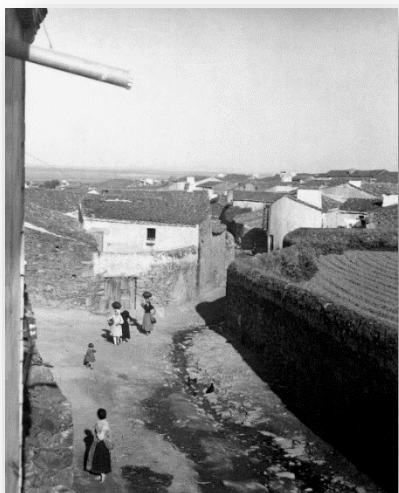
Vista parcial de Ibahernando desde la iglesia
